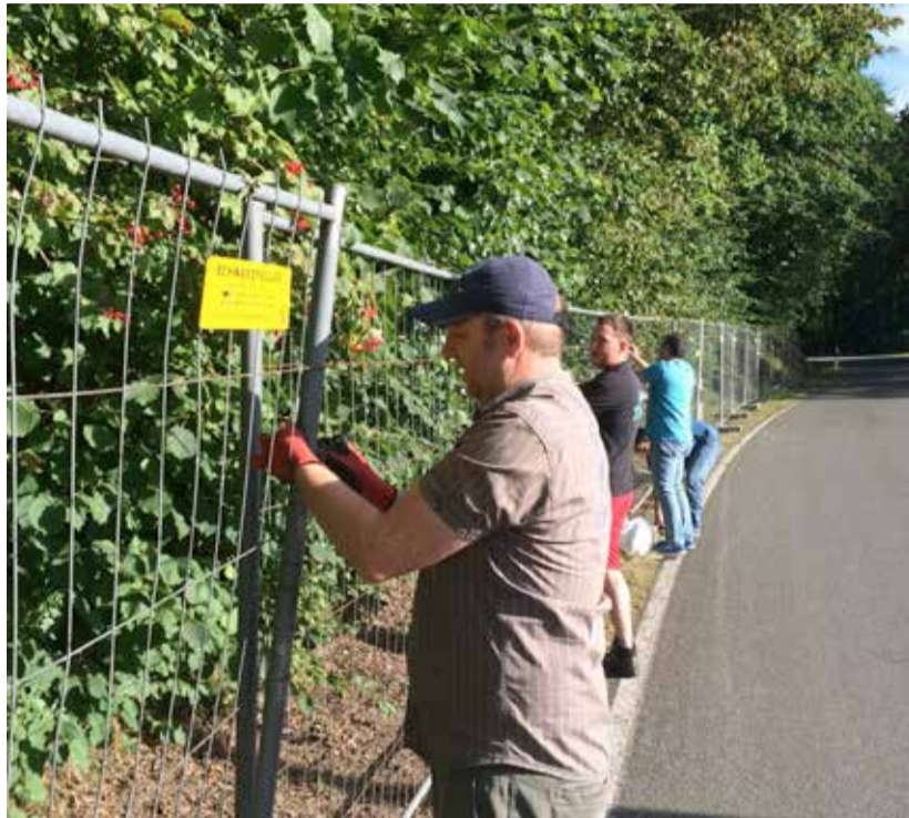
Helfer errichten den Bauzaun zur Absperrung von Konzertgelände und Zuwegung. Foto: Sigfried Girreser
