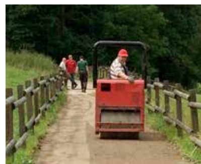
Karl Hartmann verdichtet das neu angefüllte Material auf dem Fahrradweg mit einer Walze
